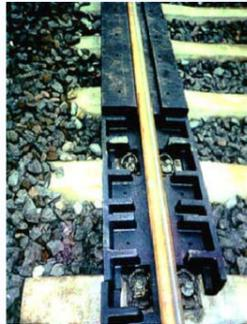
Bei Verwendung der "Spreepolymer-Schienenranrofile" kann auf die Instandhaltungsträchtige Beischiene oder auf das Herstellen von Spurrillen im Bitumen völlig verzichtet werden.
